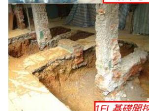
1FL基礎開挖
