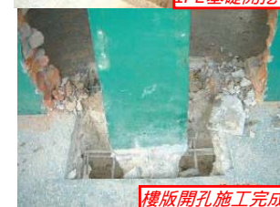
樓版開孔施工完成
