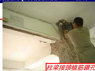
柱植筋鑽孔
