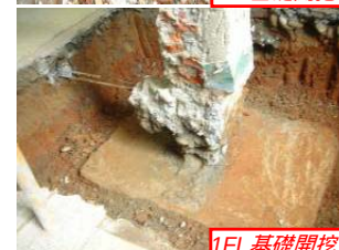
1FL基礎開挖
