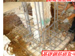
基礎鋼筋綁紮中
