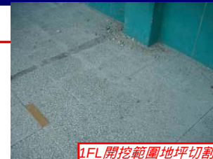
1FL開挖範圍地坪切割
