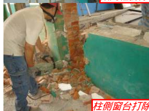
柱側窗台打除
