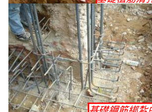
基礎鋼筋綁紮中
