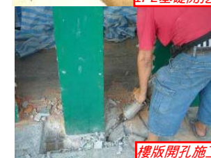
樓版開孔施工
