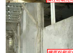
牆面粉刷完成
