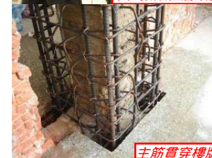
梁柱接頭植筋鑽孔
