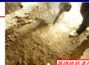
基礎植筋清孔
