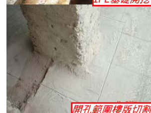
開孔範圍樓版切割
