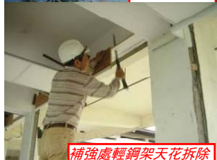
補強處輕鋼架天花拆除
