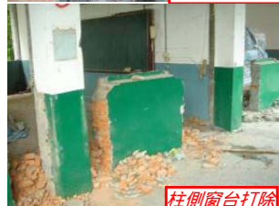
柱側窗台打除
