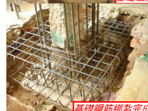
基礎鋼筋綁紮完成
