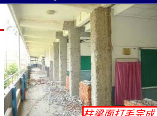
柱梁面打毛完成
