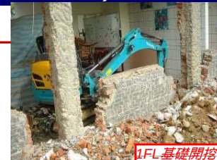
1FL基礎開挖
