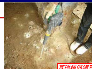
基礎植筋鑽孔
