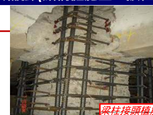
梁柱接頭植筋鑽孔
