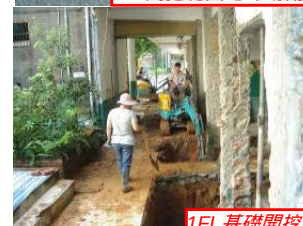
1FL基礎開挖
