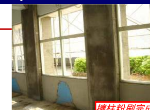
擴柱粉刷完成
