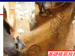
基礎植筋放樣
